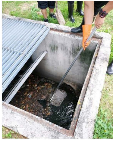
ภาพที่ 3-1 การดูแล บำรุงทำความสะอาดรางระบายน้ำ
